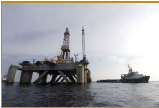
Opération d'ancrage d'une plateforme pétrolière au large de l'Angola (Photo Bourbon)
