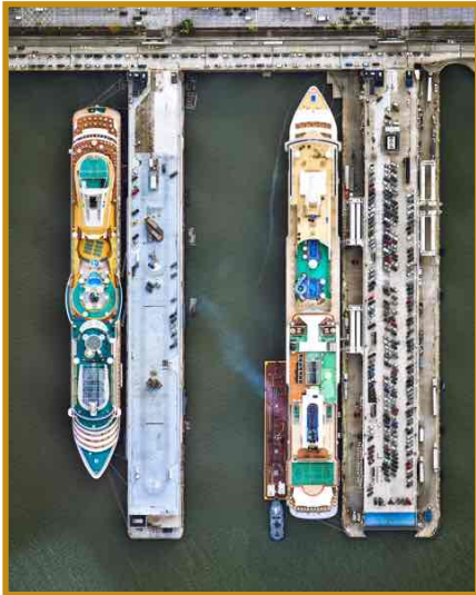
Les quais 88 et 90 du terminal de croisières de Manhattan qui accueillent plus d'un million de passagers par an.
